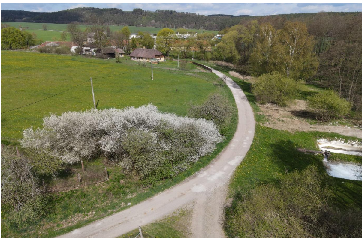
Lomany – celkový pohled
